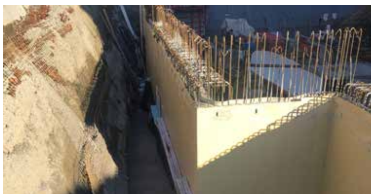
Bild 3: Die Außenwände mussten abgedichtet werden
