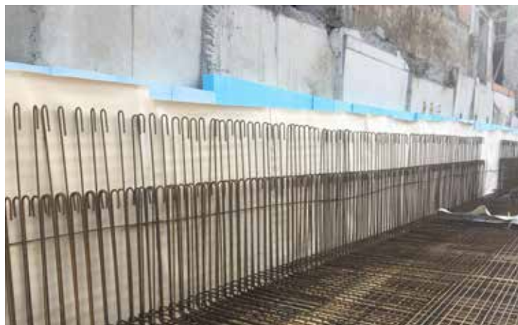
Bild 2: Abdichtung im Bodenbereich inkl. Wandaufkantung
