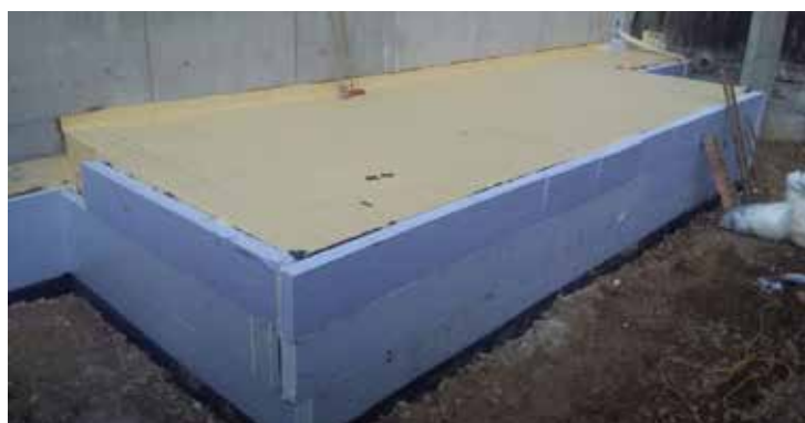
Bild 4: Abdichtung der Deckenplatte mit SikaProof® P
