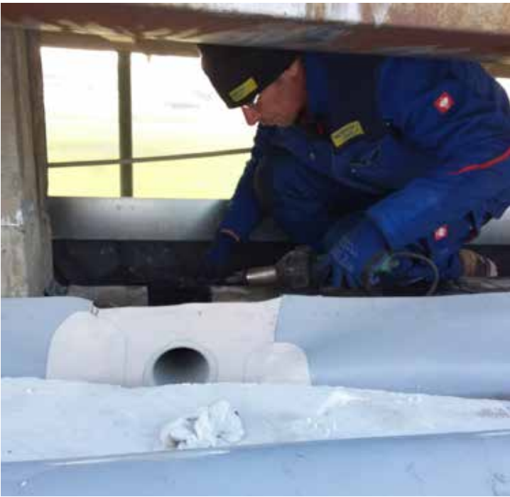
Bild 4: Keine offene Flamme bei der Montage durch Heißluftverschweißung
