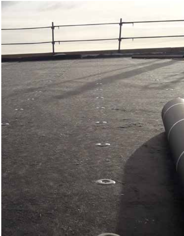
Bild 2: Sarnaweld Teller 6,8-TPO auf Holzuntergrund
