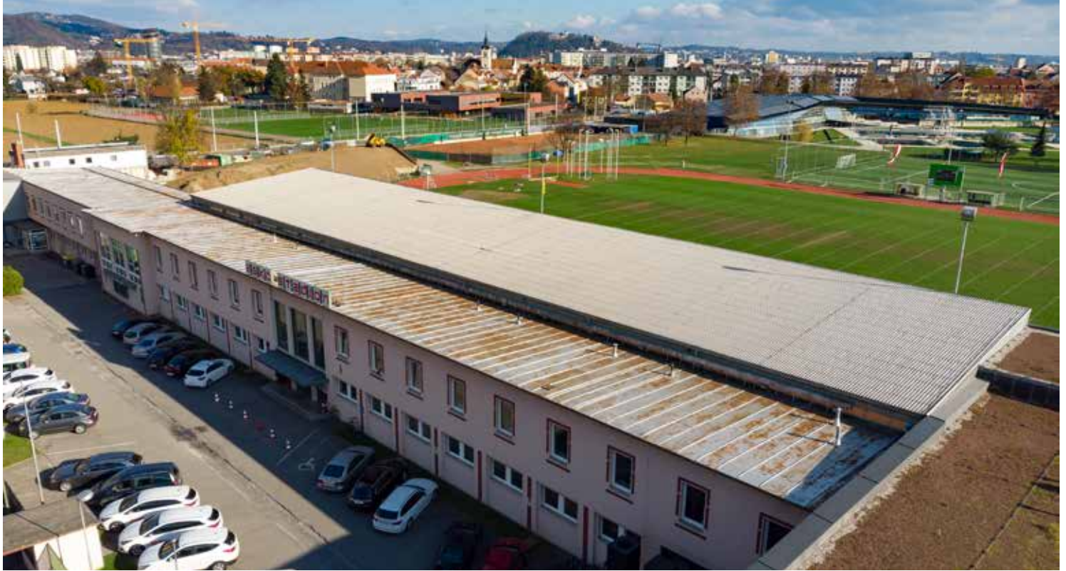
Bild 1: Altbestand des ASKÖ Stadions vor den Sanierungsarbeiten
