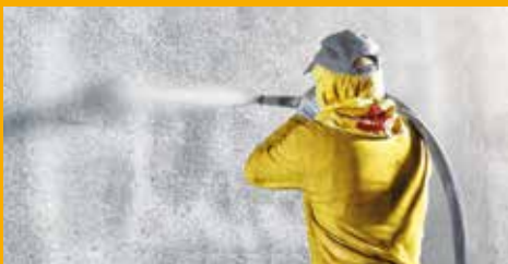
BETONSCHUTZ UND INSTANDHALTUNG
