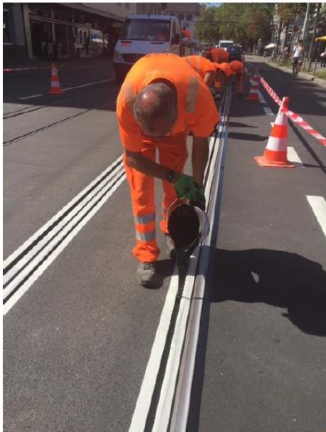
Abbildung 5 – Auftrag von Sikaflex®-406 KC direkt aus dem Metalleimer
