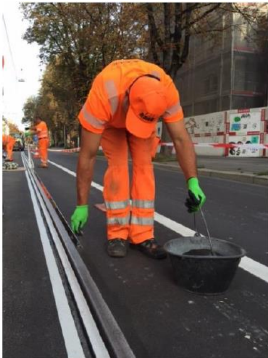
Abbildung 6 – Absanden von Sikaflex®-406 KC mit Quarzsand
