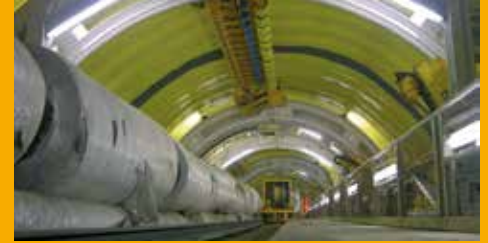
TUNNELBAU UND BAUWERKSABDICHTUNG
