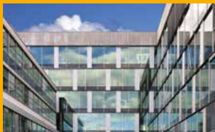
Kleben und Dichten im Fassadenbereich
