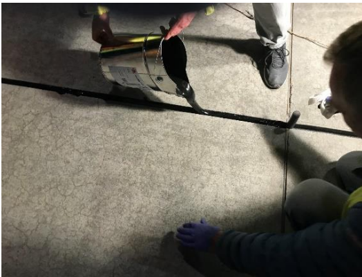
Abbildung 3 – Auftrag von Sikaflex-406 KC direkt aus dem Metalleimer
