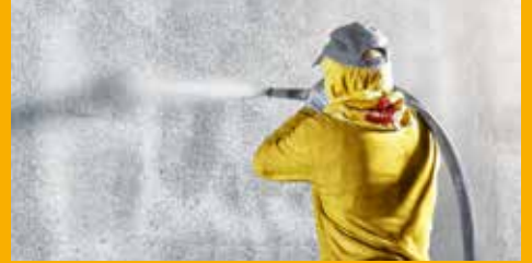
BETONSCHUTZ UND INSTANDHALTUNG
