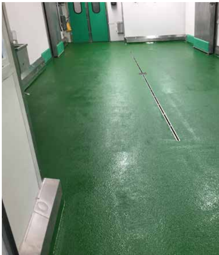
Bild 1: Sikafloor®-390 N erfüllt die hohen Ansprüche in der Lebensmittelindustrie
