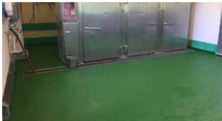
Bild 2: Abläufe werden plan in den Boden integriert
