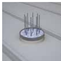
SikaProof® Detail- ausführung, z.B. für Bohrfahlköpfe
