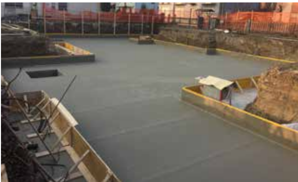
Typische Anwendung von SikaProof® A+ unter der Fundamentplatte auf der Sauberkeitsschicht.
