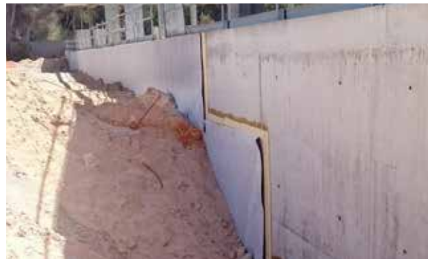
Bei offenen Baugruben ist der Schutz der SikaProof® P Abdichtung sehr wichtig, insbesondere bei der Hinterfüllung.
