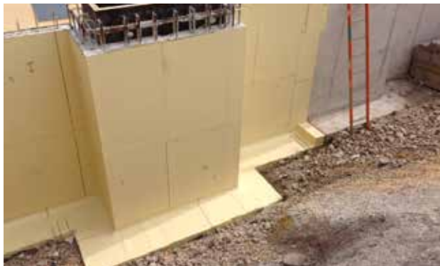
Offene Baugrube: Wandvorsprung abgedichtet mit dem SikaProof® P System.
