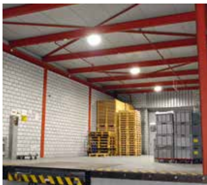
NEUE BELEUCHTUNG FÜR FABRIKEN UND LAGER, SIKA EMEA MEHRERE STANDORTE IN EUROPA
