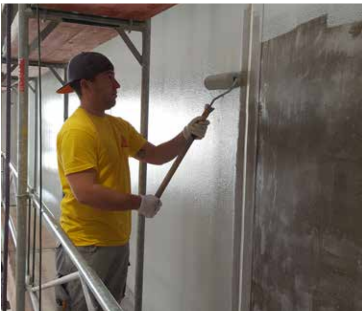
Bild 5: Wandbeschichtung mit Sikafloor®-390 N
