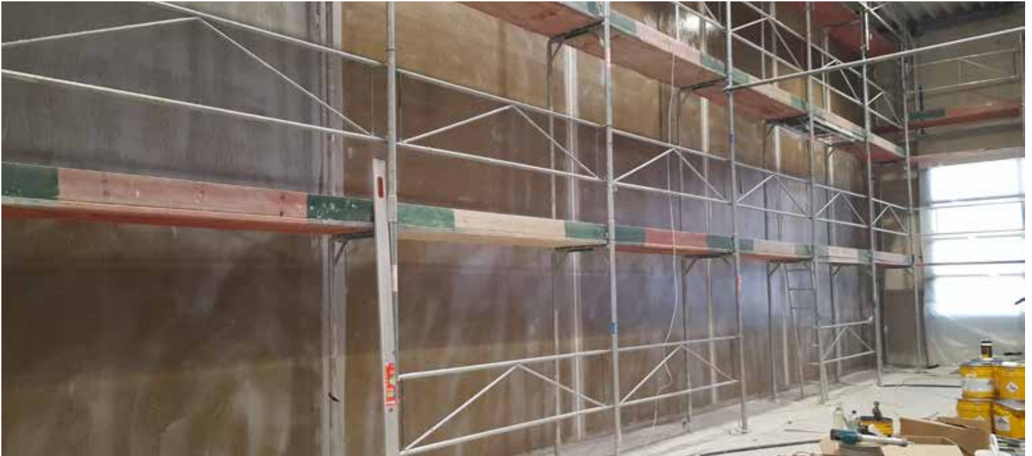
Bild 4: Nach Trocknung der Grundierung konnte die Beschichtung aufgetragen werden
