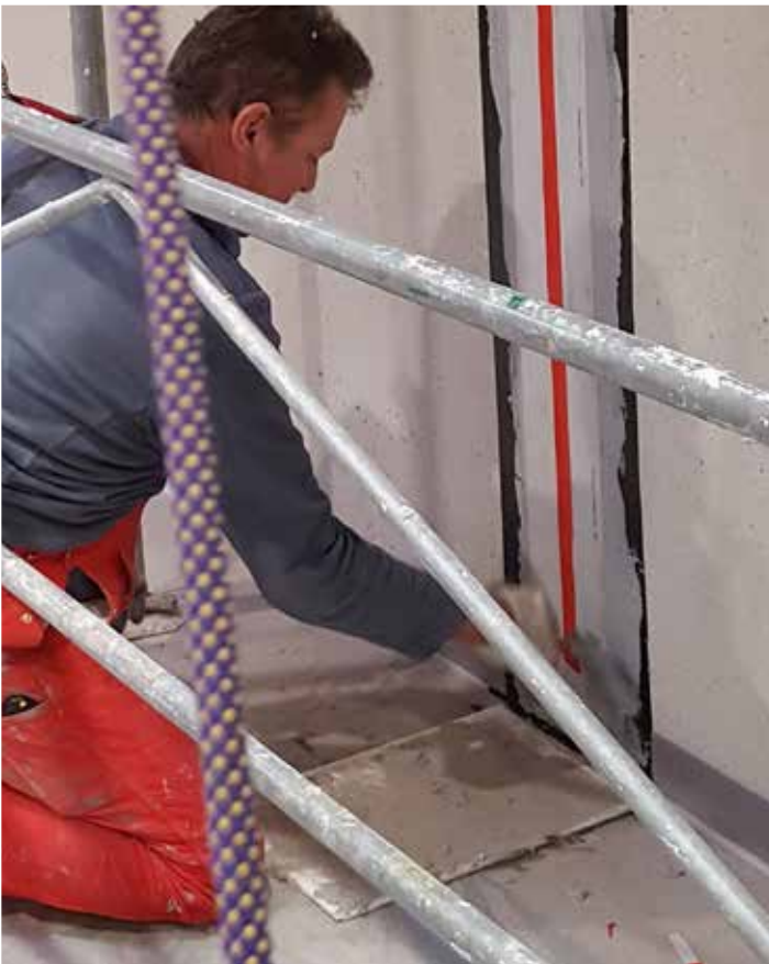
Bild 2: Bei allen Fugen kam das Sika Combiflex® System zum Einsatz
