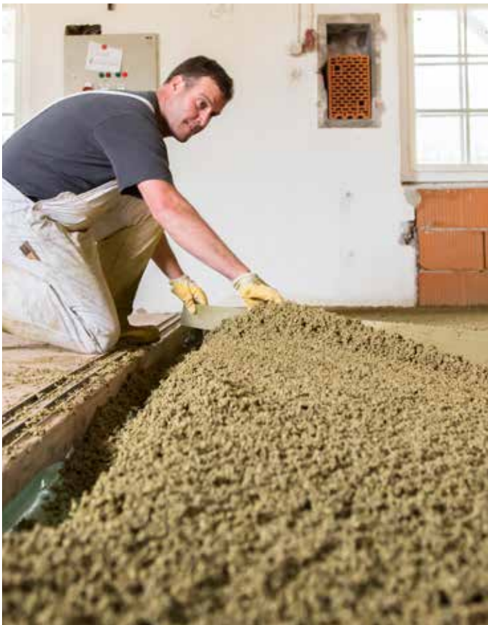
Bild 3: Vollflächiger Einbau von SikaCrete® Silent-90
