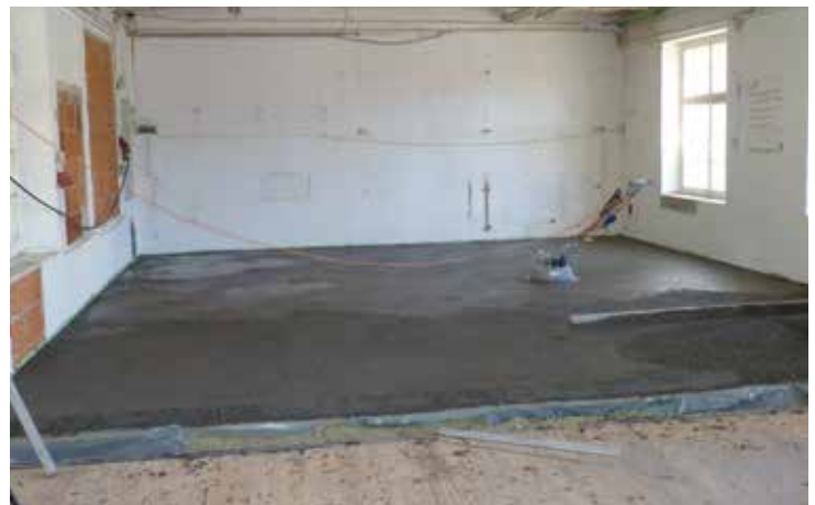
Bild 9: Der Estrich ist bereits nach 5 Stunden begehrbar
