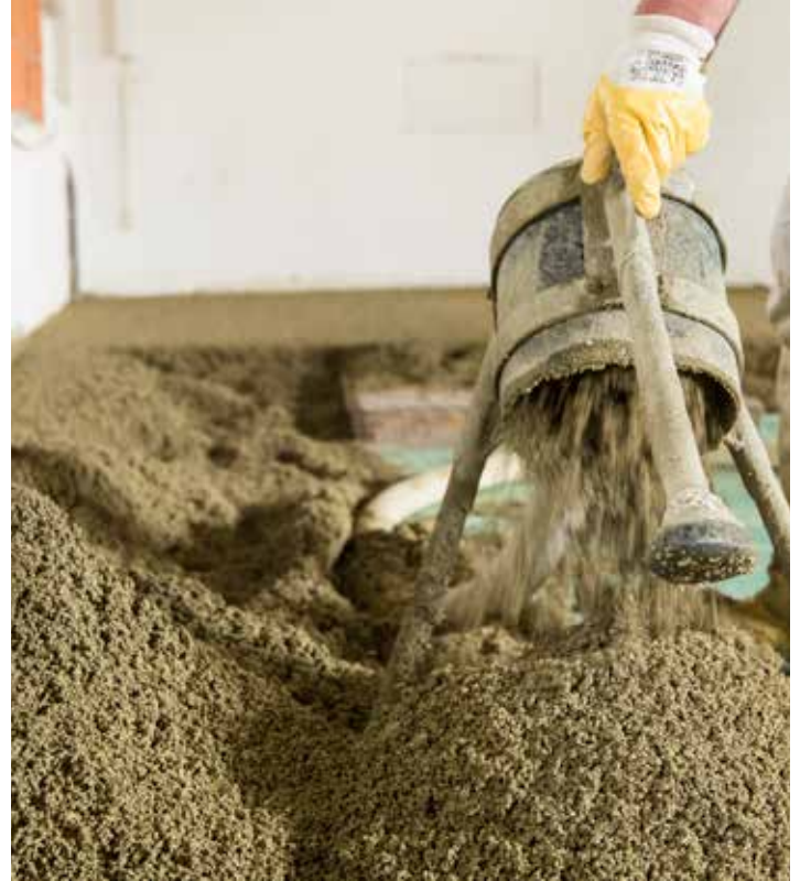
Bild 2: SikaCrete® Silent-90 wird auf die Dampfsperre aufgebracht
