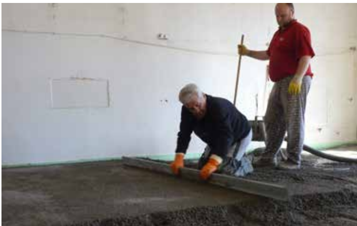
Bild 8: Einbau des hochfesten und schwundarmen Schnellestrichs
