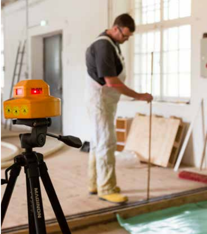
Bild 1: Lasermessungen ermöglichen genaues Arbeiten
