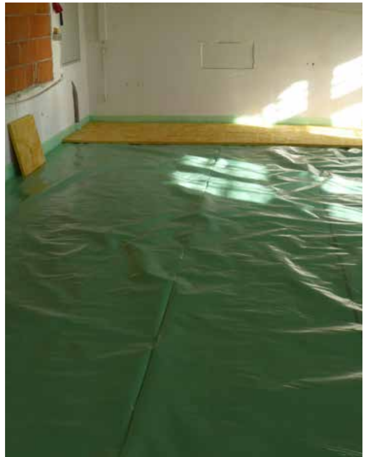
Bild 4: Sauber verlegte Dampfsperre Sarnavap® 1000 E
