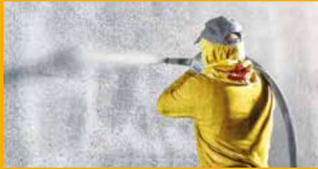
BETONSCHUTZ UND INSTANDHALTUNG
