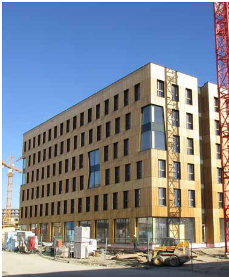
Bild 1: Der erste Bauteil des HoHo Wien ist bereits fertig und zeigt seine Schönheit
