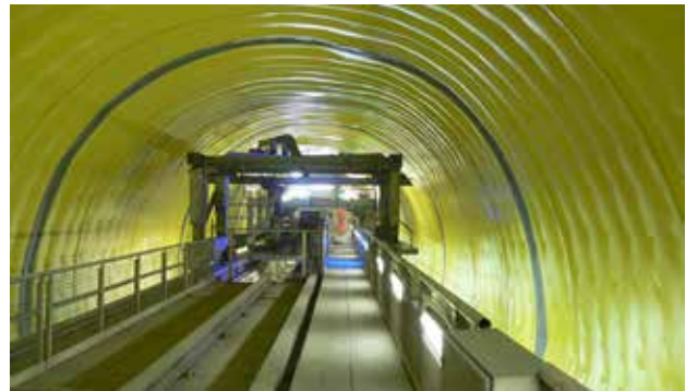
Dauerhafte Abdichtungssysteme appliziert nach der Spritzbetonsicherung und vor dem Innenringbetonausbau
