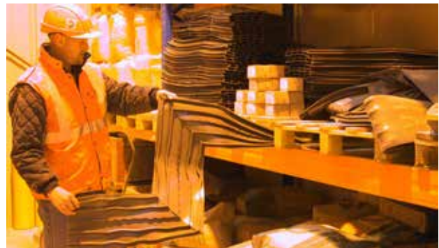
Um immer lieferbereit zu sein wurde auf der Baustelle ein Lager mit den wichtigsten Produkten eingerichtet “Shop on the Job”.
