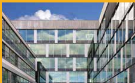
Kleben und Dichten im Fassadenbereich
