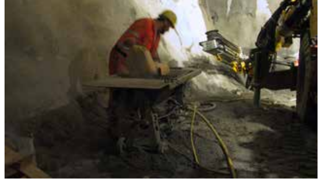
Temporäre Ausbruchsicherung mit Trockenspritzmörteln
