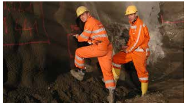
Fachleute der Sika vor Ort bei der Frühfestigkeitsprüfung von Spritzbeton
