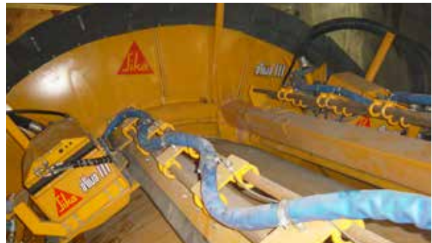
Spritzbetonsicherung hinter dem Ausbruch mit Nassspritzbeton im TBM-Vortrieb
