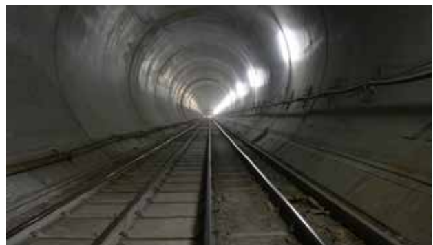
Innenringbeton als dauerhafter Endausbau der beiden Haupttunneln
