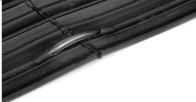
Im Bereich von Formteilen und Stumpfverbindungen sind die integrierten Injektionskanäle beidseitig jeweils um ca. 10 cm abzutrennen und mit einem flexiblen Verbindungsschlauch, Außendurchmesser = 8 mm, zu überbrücken.
