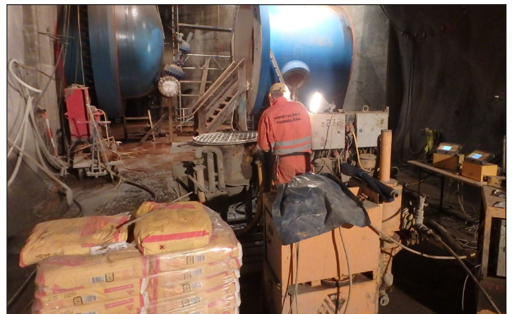
Bild 8: Injektionsgeräte und Druckrohrleitung im Hintergrund
