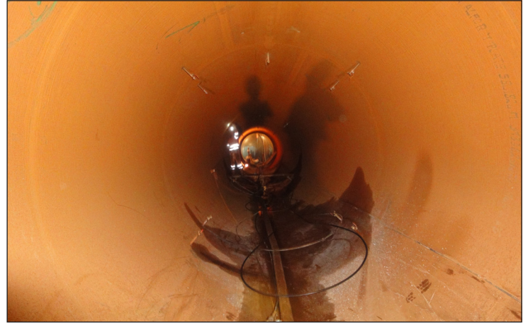
Bild 6: Verpressöffnungen im Druckrohr
