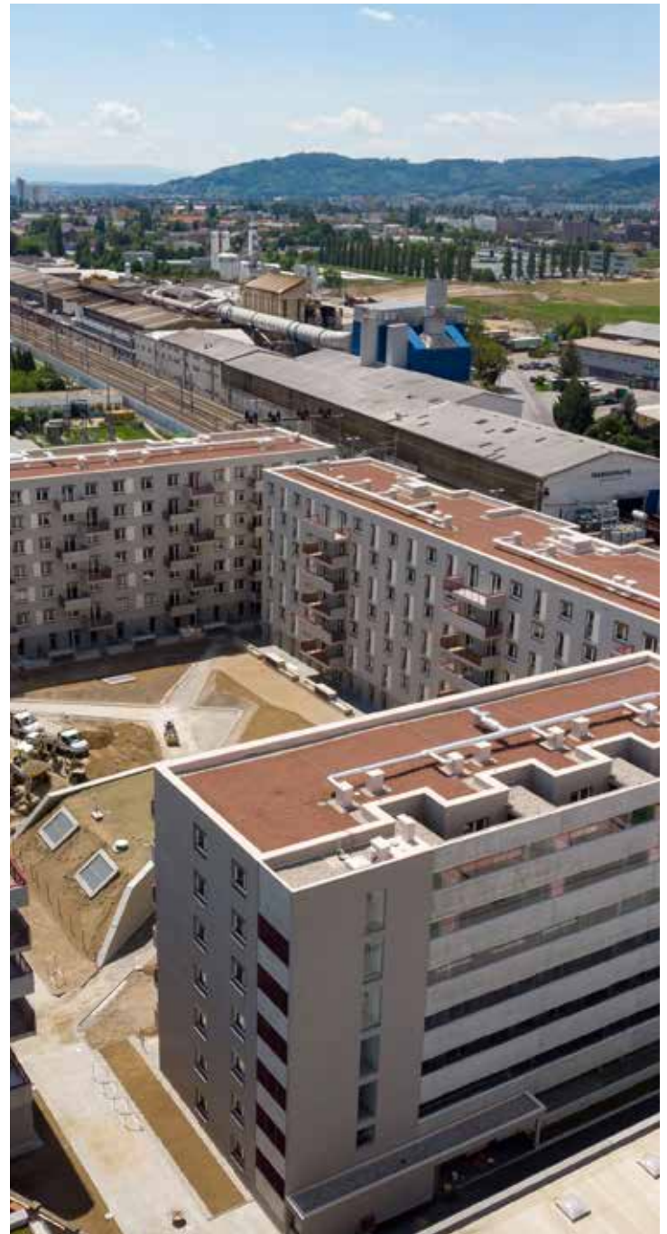
Bild 5: In kurzer Zeit entstehen hier extensiv begrünte Dächer
