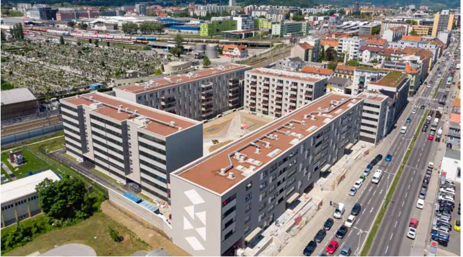
Bild 6: Gesamtüberblick über die fertige Wohnhausanlage mit rund 5.000 m 2 Dachfläche
