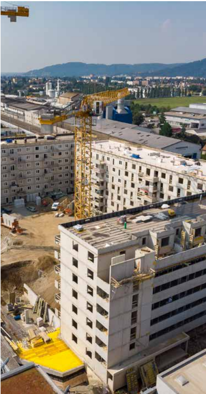
Bild 4: Als Dampfsperre wurde Dörr-Tiralbit E-ALGV-4K verlegt
