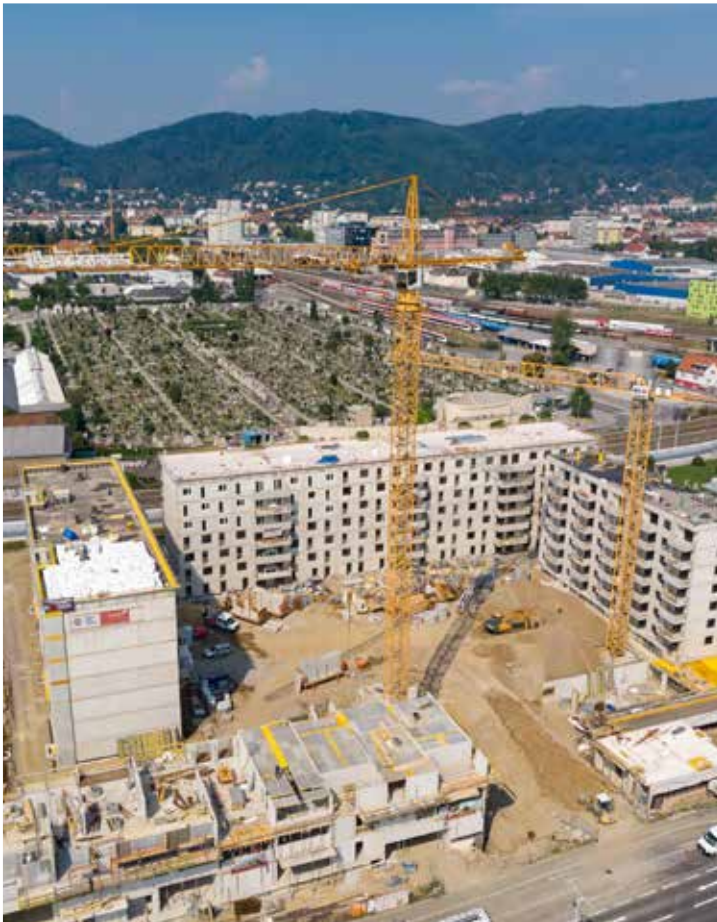
Bild 2: Blick in den Innenhof
