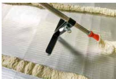
7. SikaRoof® Board Adhesive direkt auf den Untergrund auftragen und die Wärmedämmplatte mit leichtem Druck auf den Untergrund ausrichten.
