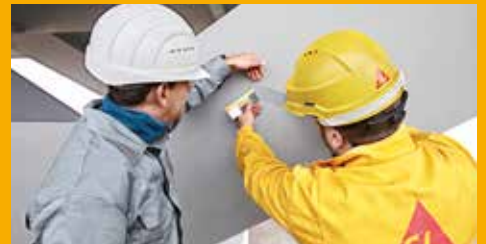
SERVICE UND BERATUNG AUF DER BAUSTELLE
