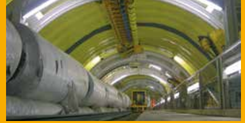
TUNNELBAU UND BAUWERKSABDICHTUNG
