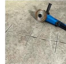
1. Rissflanken aufweiten und alle 15 - 20 cm quer einfräsen.
