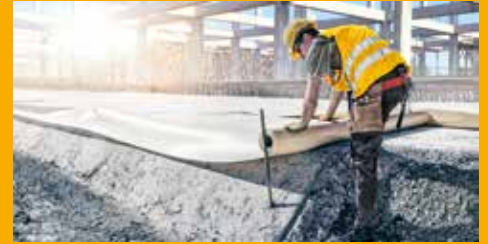
TUNNELBAU UND BAUWERKSABDICHTUNG
