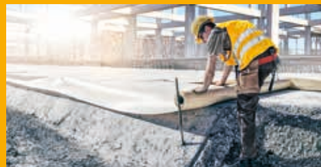
TUNNELBAU UND BAUWERKSABDICHTUNG
