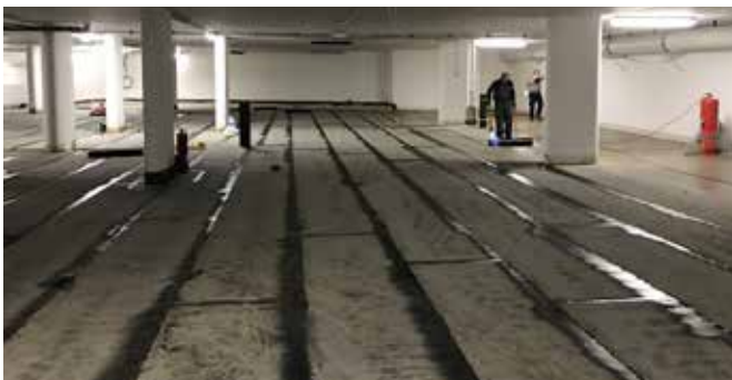
Vollflächiges Aufklämmen der 1. Bitumen-Abdichtungslage Dörr-Tiropont® EL-2/5K
