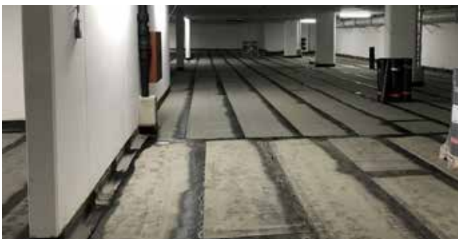
Herstellen der Wandanschlüsse mit Bitumenbahnen-Kurzstücken
