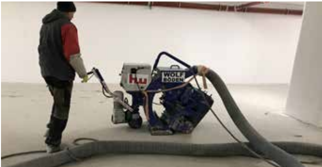
Oberflächenvorbehandlung zum Trennen der Zementschlämme sowie zur Herstellung der geeigneten Rautiefe bzw. Ebenheit
