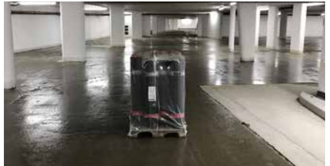
Grundierung und Versiegelung mit Sikadur®-188 auf die vorbehandelte Betonfläche
