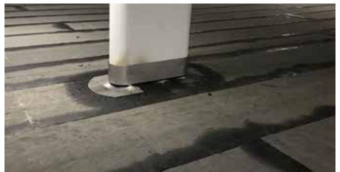
Herstellen von Schutzblechen aus Edelstahl im Bereich der Hochzugsabdichtungen
