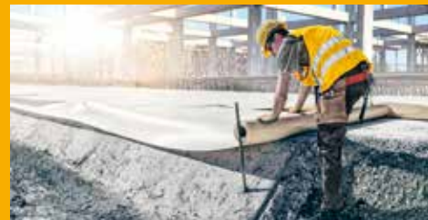
TUNNELBAU UND BAUWERKSABDICHTUNG
