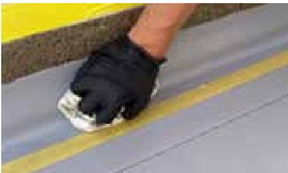
Abdichtungsbahnen und Metalluntergründe mit Sarnafil® T Clean oder Sika® Aktivator-205 und einem trockenen und sauberen Tuch reinigen. Die Ablüftzeit beträgt min. 30 Minuten.
