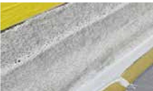
Sika® Glasfaservlies Premium/Sikalastic® Rapid Fleece-110 in die nasse Beschichtung einlegen und < 1 cm vom Klebeband zurückbleiben (Überdeckung mit Sikalastic®-625 N) um ein Aufreissen des Vlieses beim Entfernen des Klebebandes zu vermeiden.
