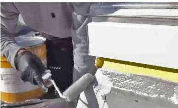
Die 1. Schicht Sikalastic®-625 N mit min. 1,0 l/m<sup>2</sup> (1,25 kg) auftragen. Auf einen ausreichenden und gleichmässigen Auftrag achten.
