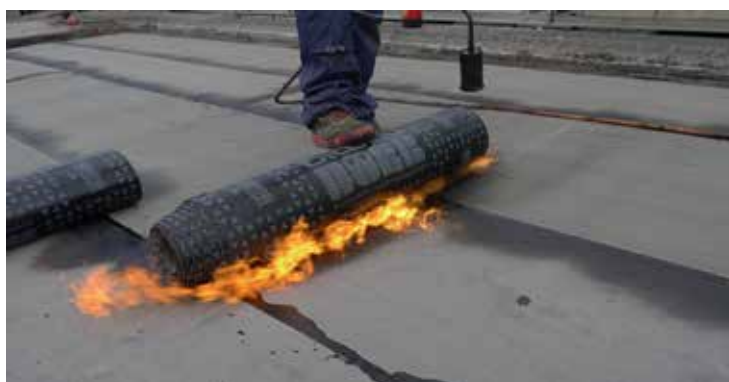
Bild 3: Verschweißen von Bitumenbahnen mittels Gasflämmer
