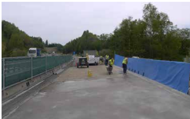
Bild 1: Epoxidabdichtung unter den Bitumenbahnen
