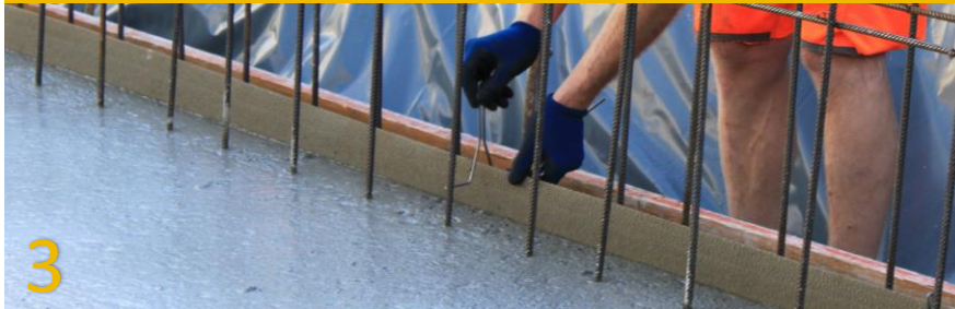
Fixieren mit Haltebügel für die folgenden Arbeitsschritte
