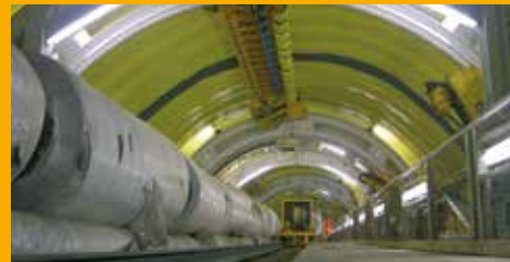
TUNNELBAU UND BAUWERKSABDICHTUNG
