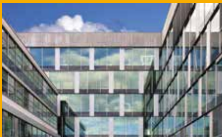
Kleben und Dichten im Fassadenbereich
