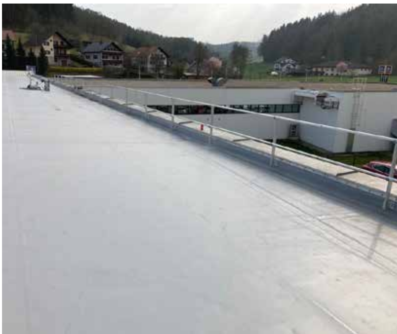
Bild 6: Die Absturzsicherung wurde mittels Geländer ausgeführt
