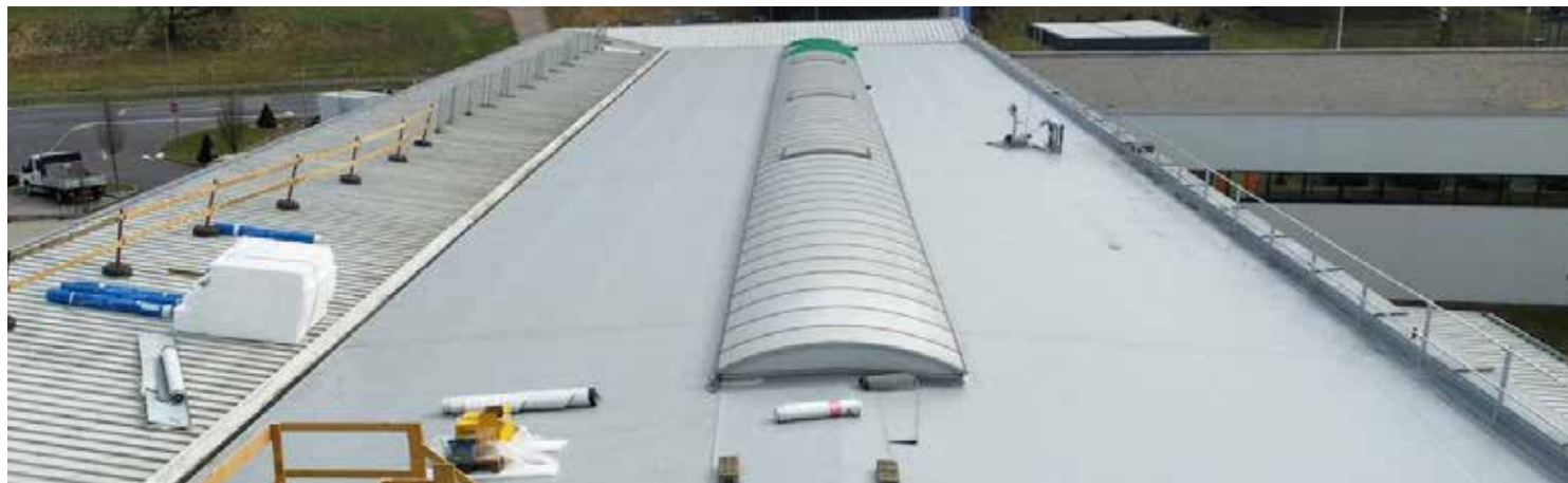
Bild 7: Die fertige Abdichtung bietet Sicherheit für viele Jahrzehnte
