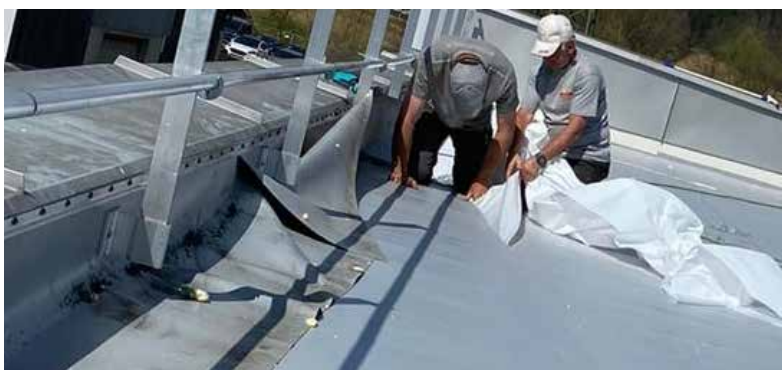
Bild 5: Aufbringen der vollflächig verklebten Dachabdichtungsbahn Sarnafil® TG 76-18 FSA
