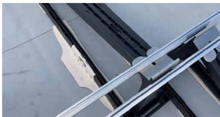
Bild 9: Sika® SolarMount Böcke werden mittels Clicks mit der Dachabdichtung verbunden
