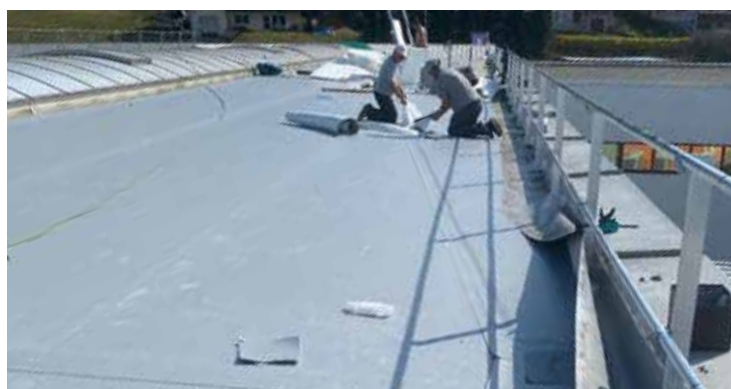
Bild 8: Zusätzliche Gefällelungen im Bereich der Entwässerung
