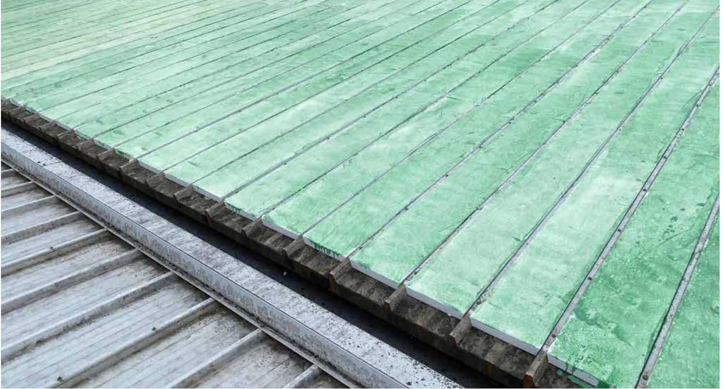
Bild 1: Wärmedämmplatten mittels SikaBond® FoamFix auf die bestehenden Dachpaneele verklebt und mit Primer-780 vorbereitet
