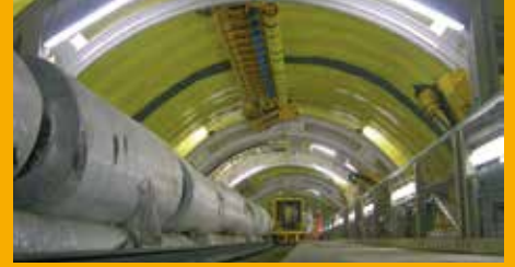
TUNNELBAU UND BAUWERKSABDICHTUNG
