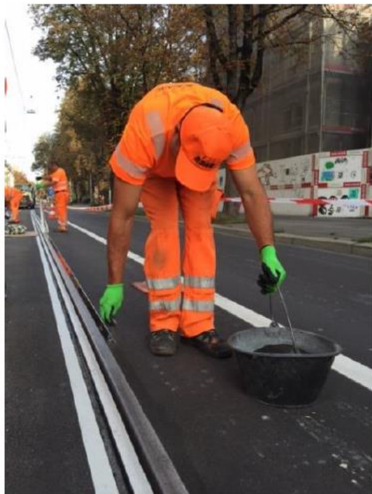
Abbildung 6 – Absanden von Sikaflex®-406 KC mit Quarzsand
