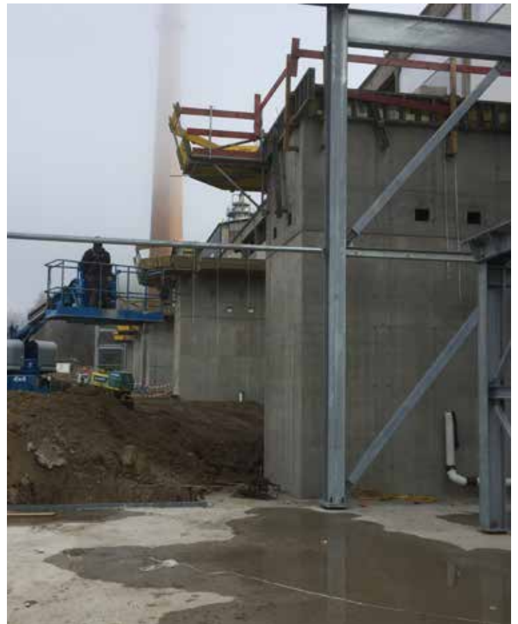
Bild 3: Die Lag sockets der Rotierofen-Fundamente werden erstellt.
