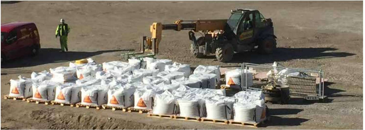
Bild 4: Die Big-Bags können schnell und einfach vom Lagerort zur Verarbeitung transportiert werden.
