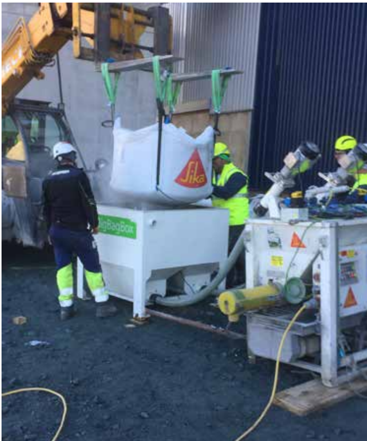
Bild 5: Die Verwendung von SikaGrout®-312 in Big-Bags ermöglicht eine staubreduzierte bzw. staubfreie Anwendung.
