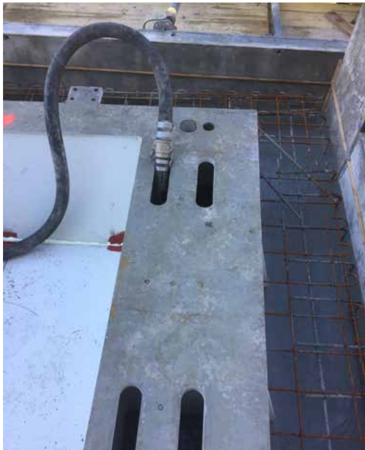
Bild 7: SikaGrout®-312 wird zum Aus- und Untergießen eingesetzt.
