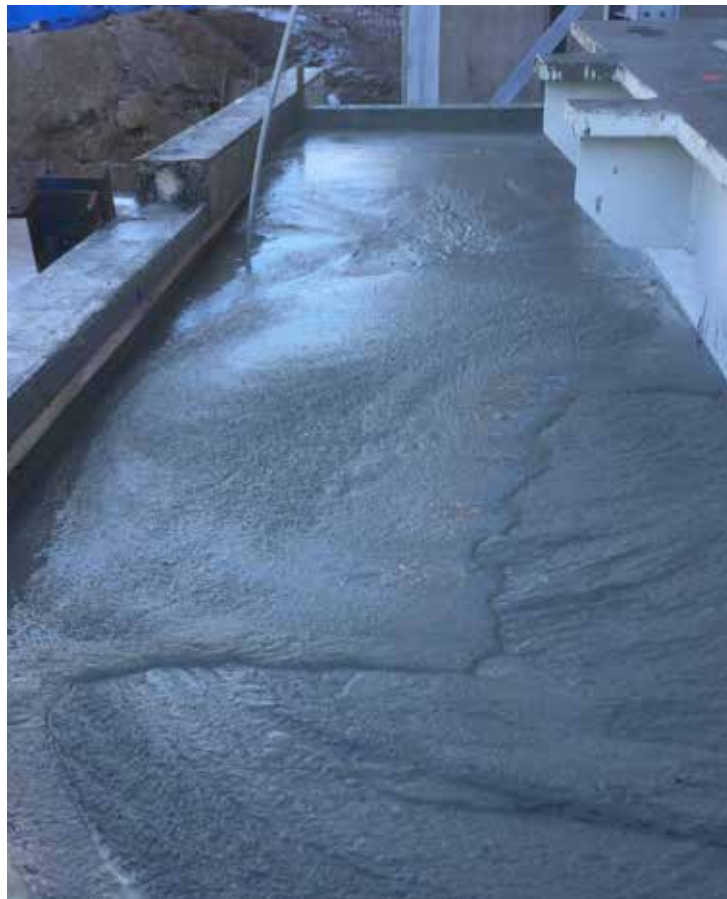
Bild 8: Hochfester Präzisionsvergussmörtel mit sehr guten Fließeigenschaften.
