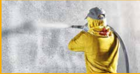
BETONSCHUTZ UND INSTANDHALTUNG
