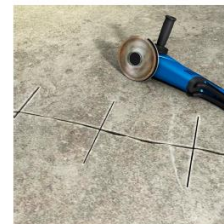
1. Rissflanken aufweiten und alle 15 - 20 cm quer einfräsen.
