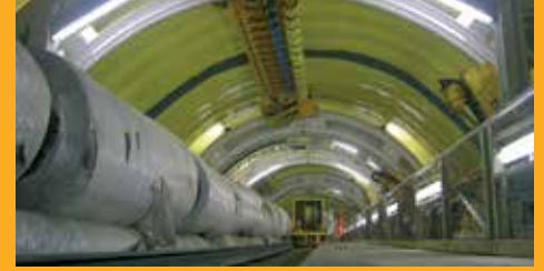
TUNNELBAU UND BAUWERKSABDICHTUNG
