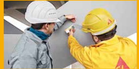
SERVICE UND BERATUNG AUF DER BAUSTELLE
