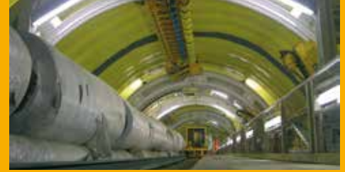
TUNNELBAU UND BAUWERKSABDICHTUNG
