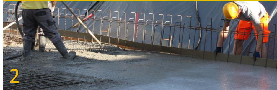
Einstecken des Fugenbandes in den Frischbeton
