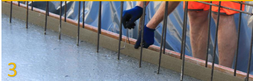
Fixieren mit Haltebügel für die folgenden Arbeitsschritte
