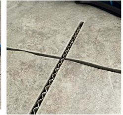
2. Wellenverbinder einlegen.
