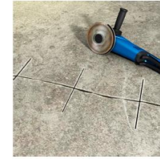
1. Rissflanken aufweiten und alle 15 - 20 cm quer einfräsen.
