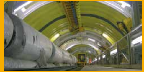
TUNNELBAU UND BAUWERKSABDICHTUNG
