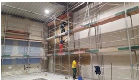
Grundierung der Wandfläche mit Sikafloor®-156, einem Bindemittel auf Epoxidharzbasis
