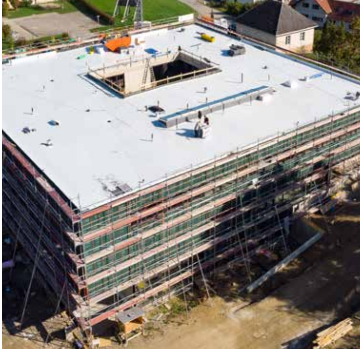
Bild 1: Beim Neubau wurde die Dachfläche mit Sarnafil® AT abgedichtet
