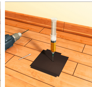
4. Aufsetzen der Spritze und ausfüllen der Hohlstelle mit SikaBond®-851 ParquetRepair Foam
