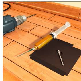
3. Aufsetzen der Nadel (bei grösseren Hohlstellen kann auch ohne Nadel ausgefüllt werden)
