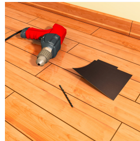
1. Abkleben der Hohlstelle
