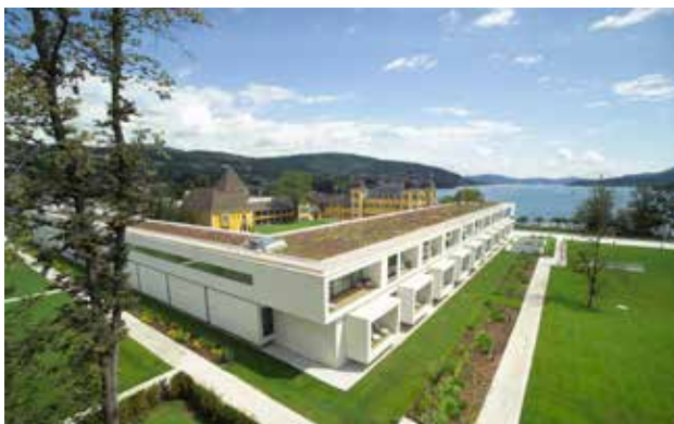
Das Dach des Schlosshotel Velden wurde mit einem Leckortungssystem ausgestattet.
