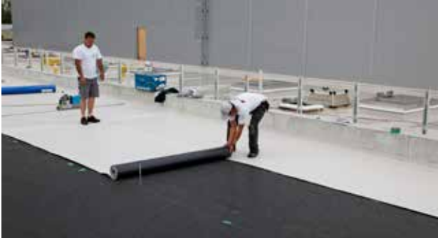
Über dem elektrisch leitfähigen Spezialglasvlies wird die Sarnafil® Kunststoffabdichtungsbahn verlegt.
