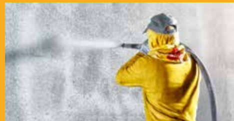
BETONSCHUTZ UND INSTANDHALTUNG
