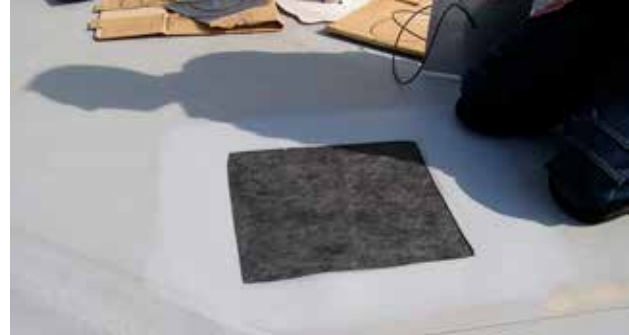
Nach der Reinigung ein Stück aus der Kunststoffabdichtungsbahn schneiden.
