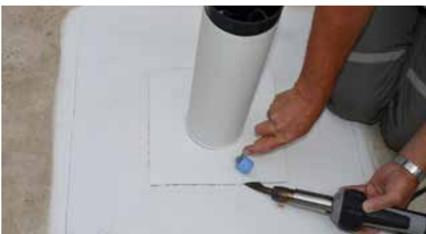
Abdichtung des Sika® RCS-Rohrs mit Sika® RCS-Einfassung und anschließend Nahtkontrolle durchführen.
