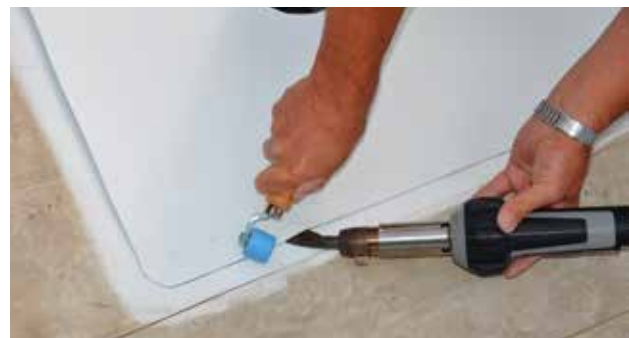
Flächenzuschnitt herstellen und aufschweißen.
