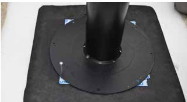
... und Sika® RCS-Rohr in den Untergrund befestigen.
