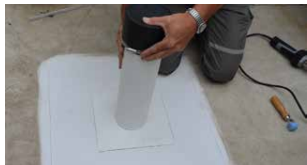
Einsetzen der Abdeckkappe mit integriertem Wärmedämmkern.
