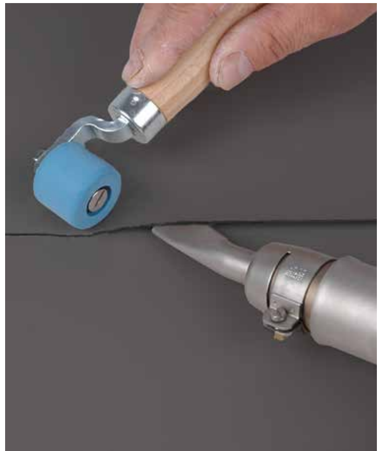
Bild 3: Einfache Verschweißung mittels Leister TRIAC AT
