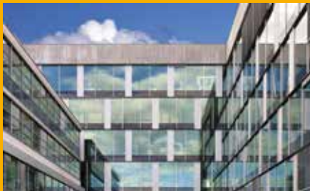
Kleben und Dichten im Fassadenbereich
