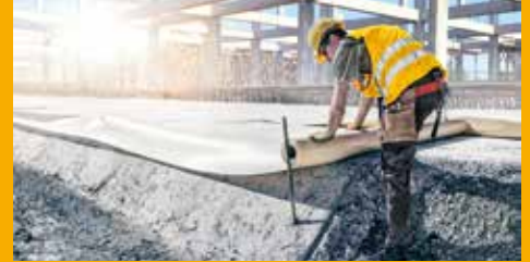
TUNNELBAU UND BAUWERKSABDICHTUNG
