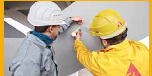
SERVICE UND BERATUNG AUF DER BAUSTELLE
