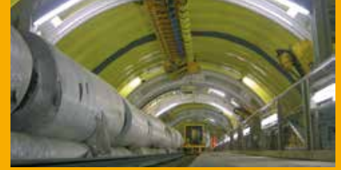
TUNNELBAU UND BAUWERKSABDICHTUNG
