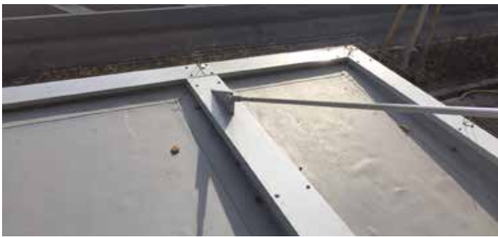
Bild 9: Überdachung der Fahrrad-Abstellplätze
