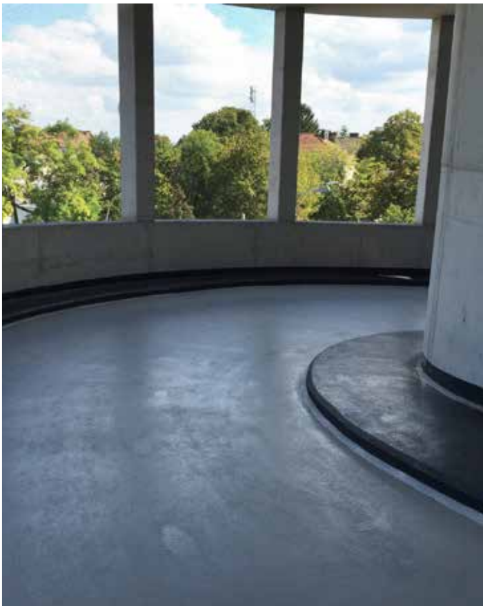
Bild 2: Über Rampen sind die vier Parkebenen verbunden
