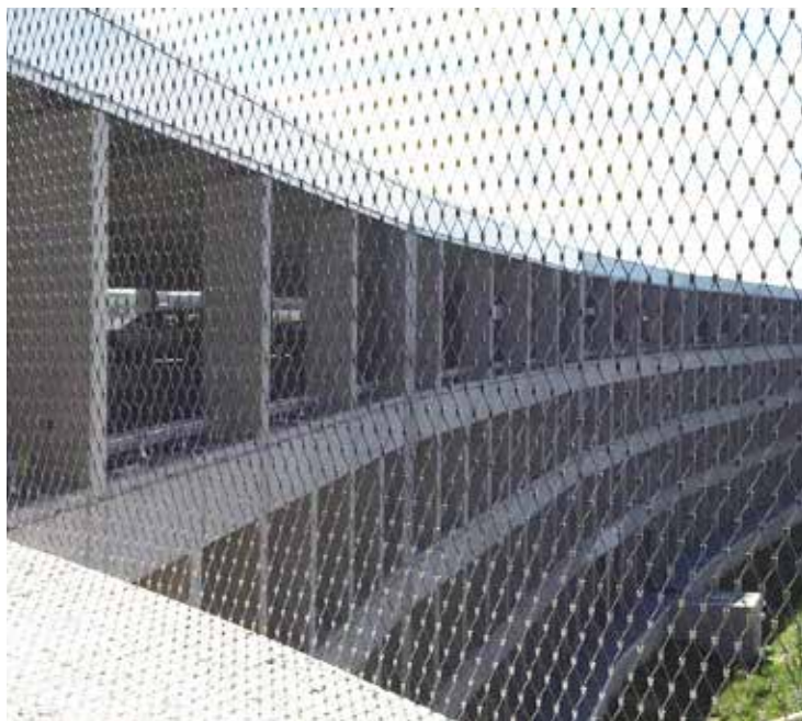
Bild 6: Auch die obersten Stellplätze sind überdacht
